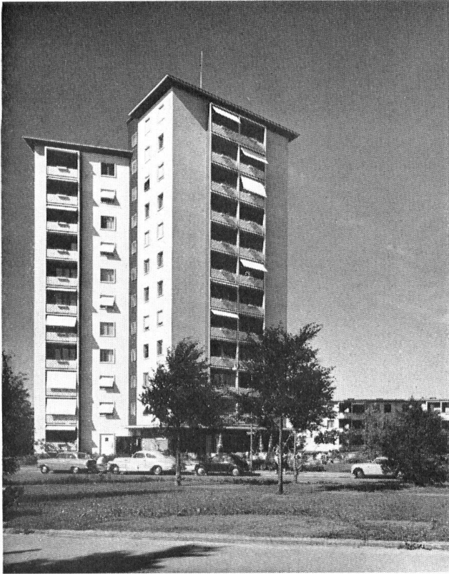
Wohnhochhaus mit sternförmigem Grundriß am Heiligfeld, Zürich. Arch. Prof. A. H. Steiner, Zürich.
