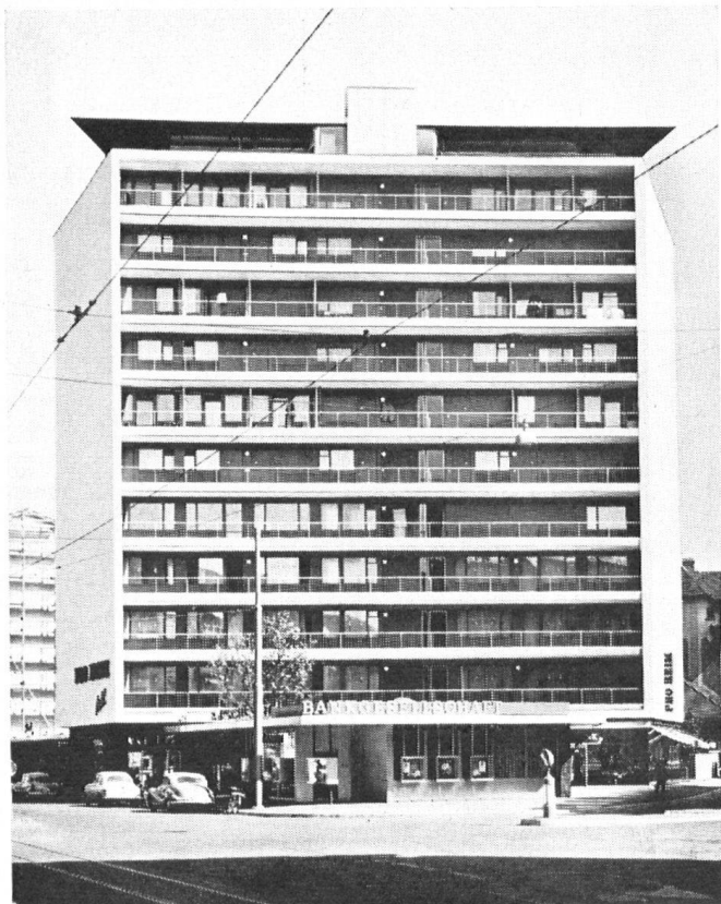
Immeuble haut à deux faces. Les horizontales dominent: effet un peu massif mais apaisant. Arch. W. Stücheli et H. Oeschger, Zurich.
