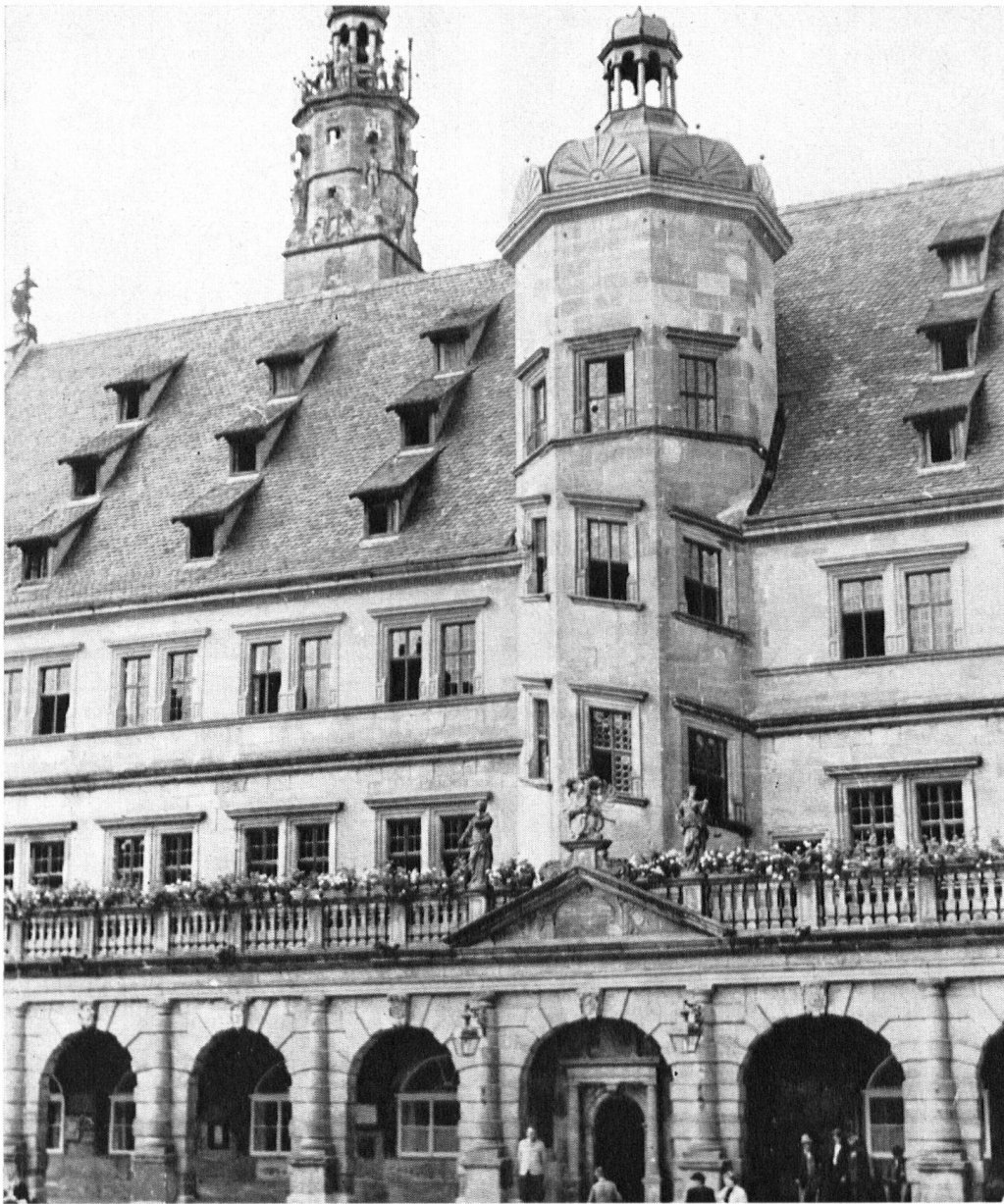
Les principales parties architecturales ayant échappé au sinistre, l'édifice a pu être fidèlement reconstitué.
