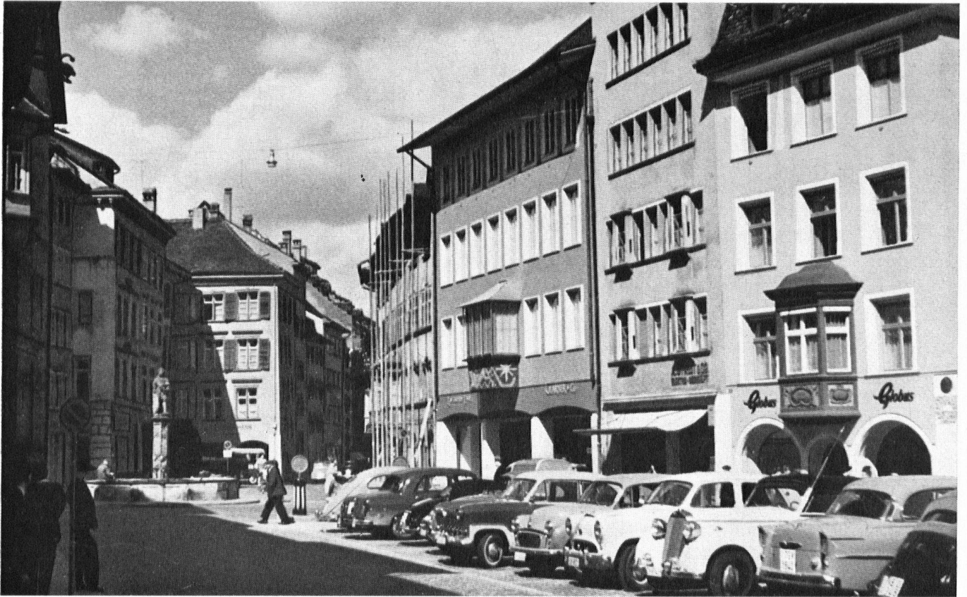
La place Fronwaag à Schaffhouse. — Il s'agissait d'y construire un grand magasin. En voici la façade (à droite de l'échafaudage). Arch. Walter Henne, président de la section schaffhousoise du Heimatschutz.
