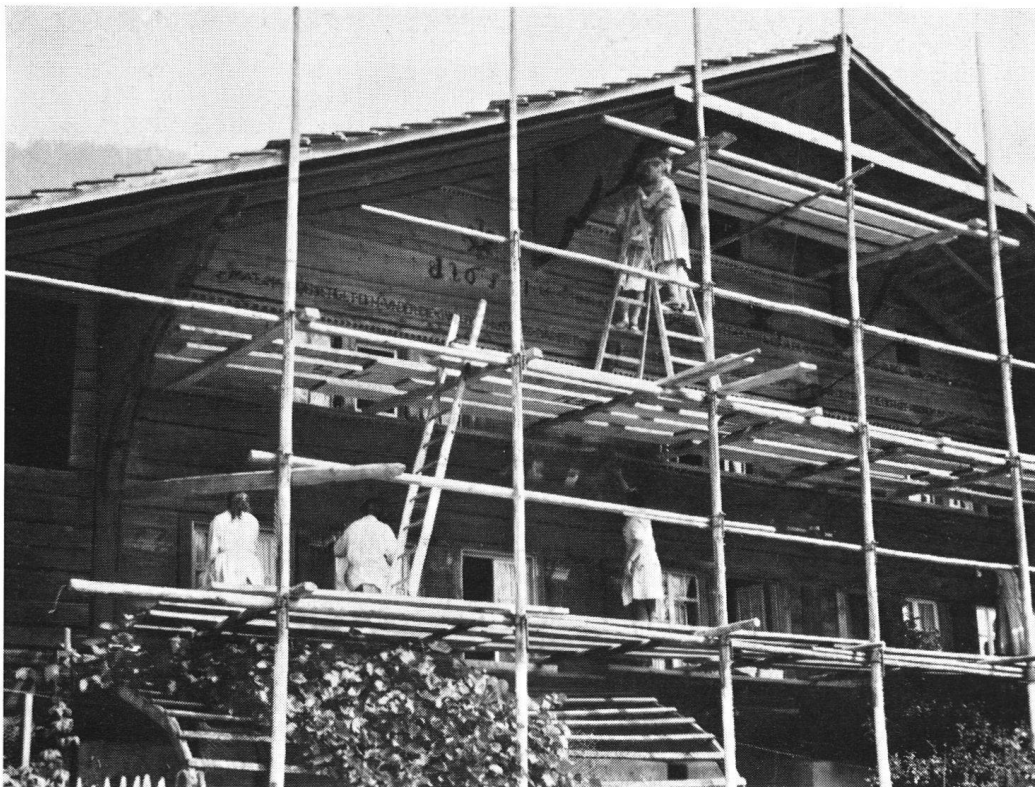
Le travail sur l'échafaudage
