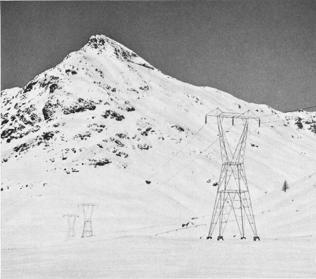
Hochspannungsleitung der Brusio-Werke über den Bernina-Paß. Rhyth- mische Belebung der sonst öden Talsenke. Im Hintergrund der Piz Albris, das bekannte Steinwild-Reservat.
