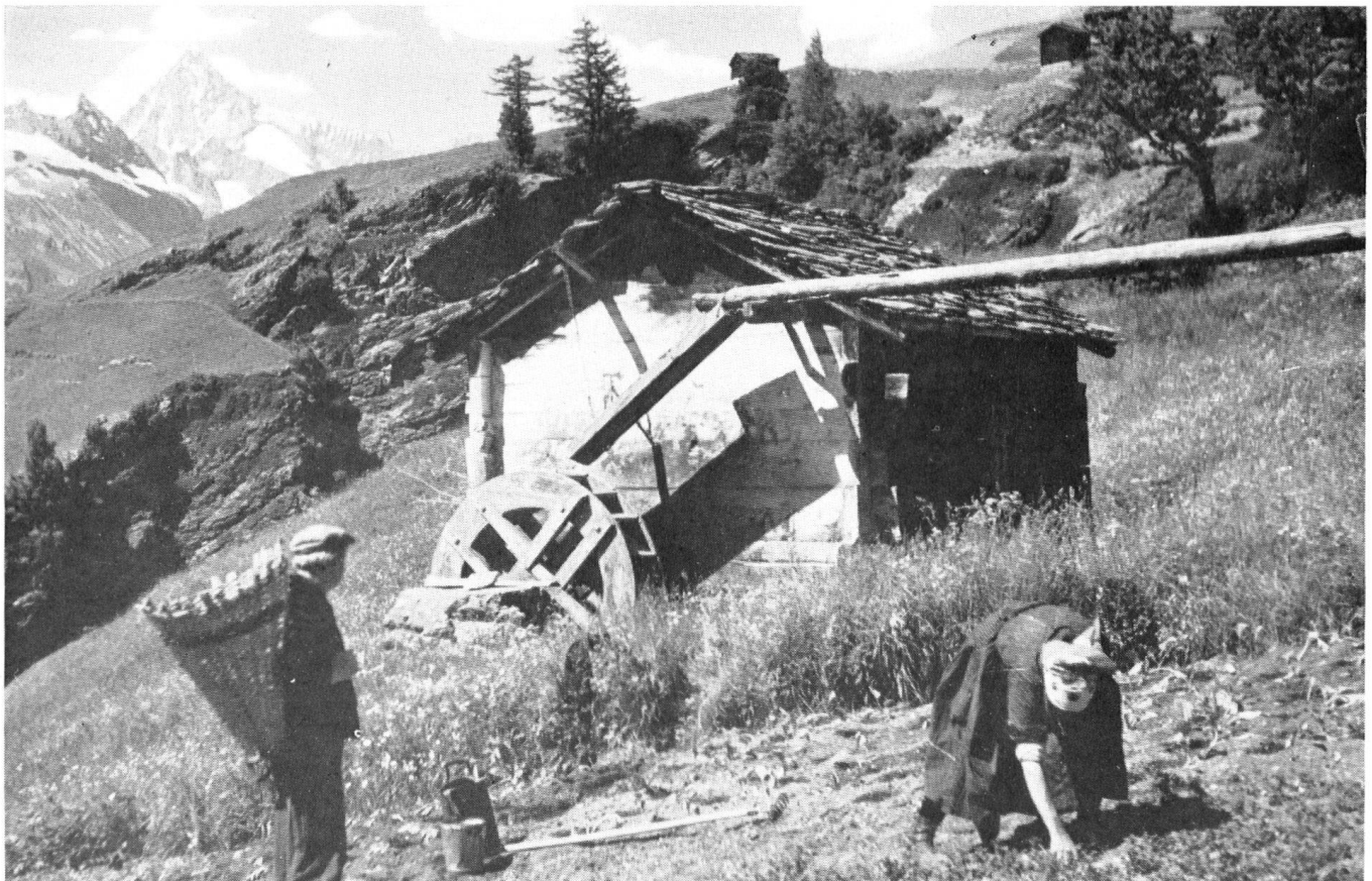
Eine Kornmühle bei Visperterminen (Wallis).
