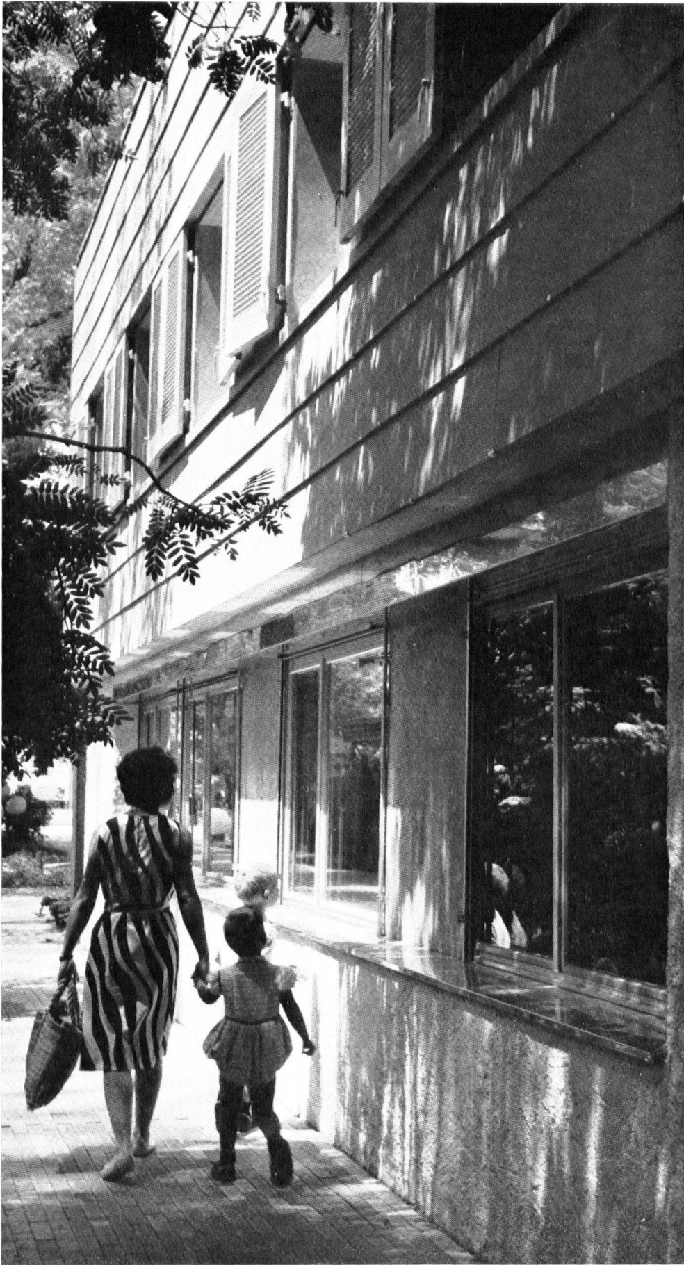
La maison d'habitation, façade sud. Au rez-de- chaussée, principales pièces; au premier étage, chambre du valet de ferme et chambres des enfants.
