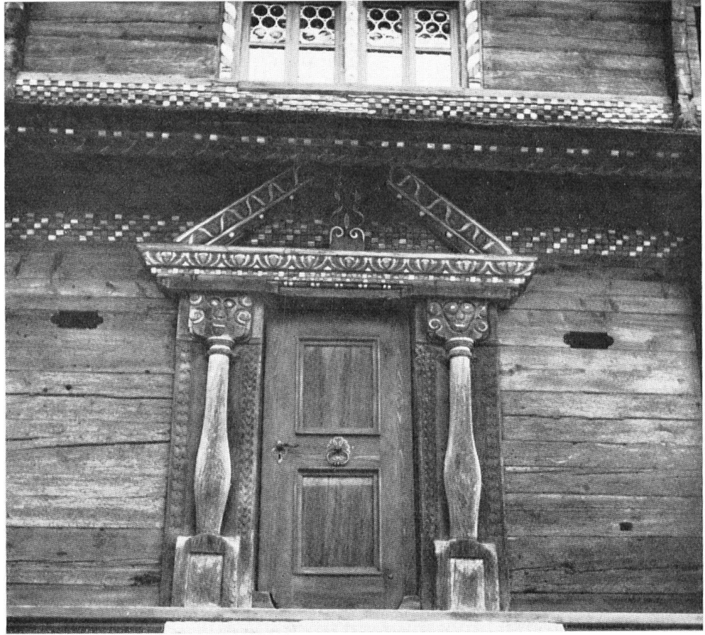
Das mit barocker Großartigkeit gestaltete Speichertor.
