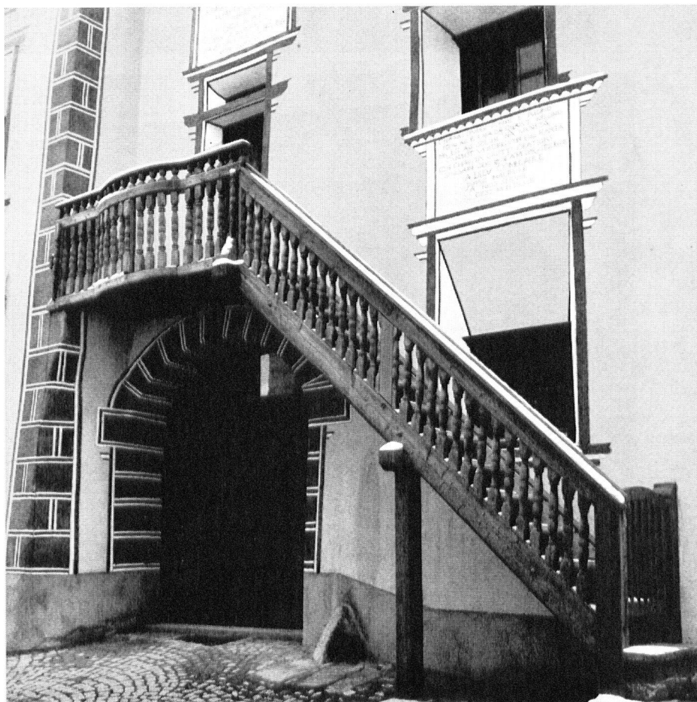
Ftan. Encore une maison engadinoise caractéristique. Bâtie en 1674 pour le pasteur J. A. Vulpius. Deux photos: l'une avant, l'autre après la restauration (1966). Entreprise pleinement réussie; nombreuses sont les demeures grisonnes qui mériteraient les mêmes soins.
