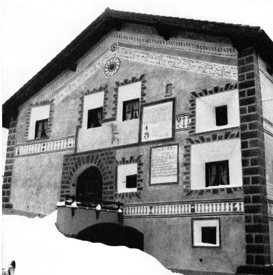
Et voici ce qu'en a fait le propriétaire actuel, à qui le Heimatschutz a voté un subside et qui avait confié la direction des travaux à l'architecte C. Kőnz à Zuoz. – Remarquer la riche décoration par graffiti.
