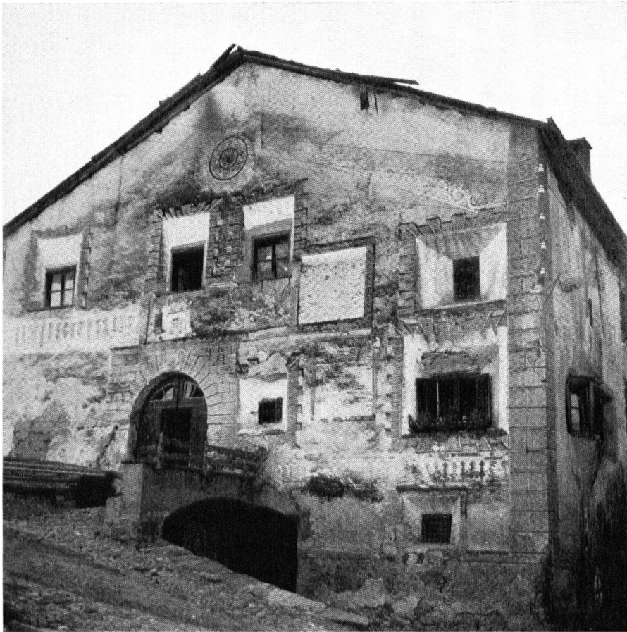
Au milieu du village d'Ardez, sur la route principale de l'Engadine, voici la maison Stupan (1816), telle que naguère elle s'offrait au regard.
