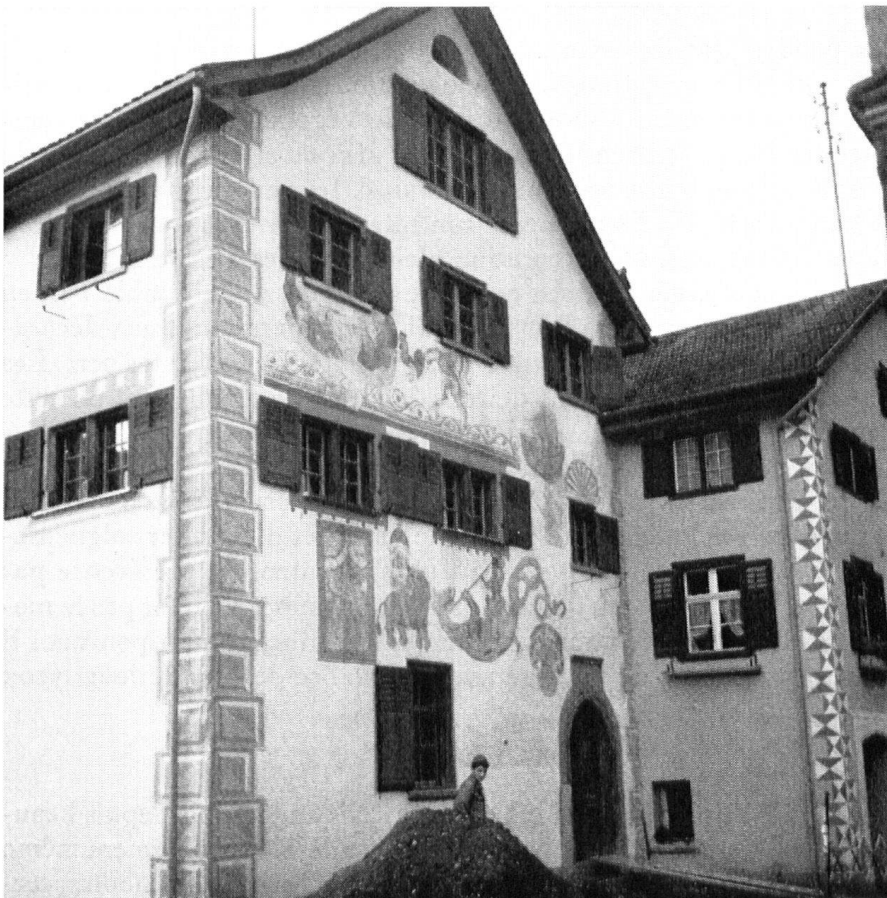
Il a fallu de longues années d'efforts, tant du Heimatschutz que du service cantonal de protection, pour aboutir au beau résultat dont témoigne cette image.
