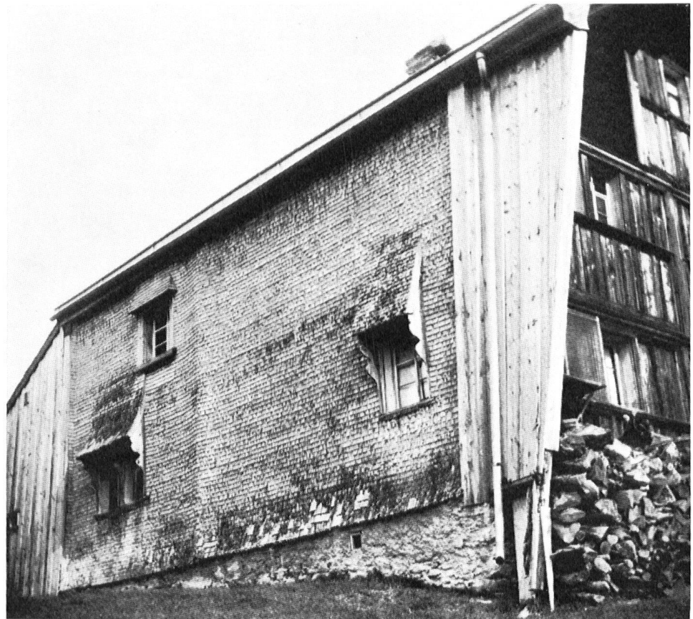
Couvertures de bardeaux. En haut, entourage des fenêtres. – En bas, une façade latérale.
