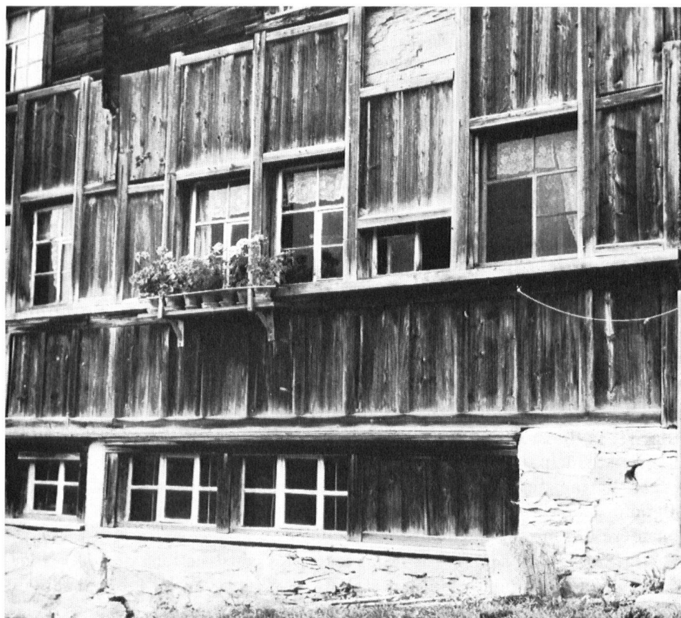
Les volets des fenêtres s'ouvrent verticalement. Au sous-sol: atelier de tissage.
