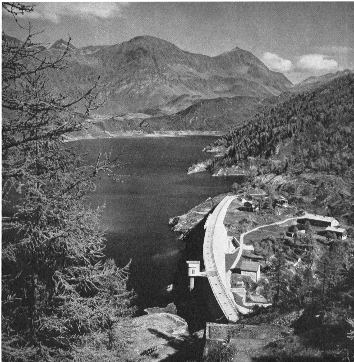
Il y a 50 ans, les C.F.F. firent du lac Ritom, tout au nord du Tessin, un bassin d'accumulation, en surélevant son niveau par un barrage. Vers 1950, seconde surélévation.
