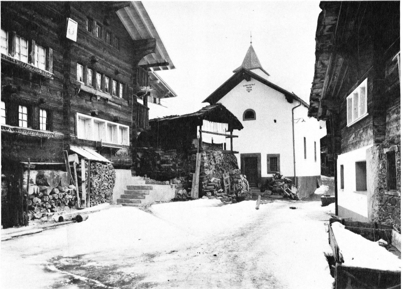
Abb. 5. Der Einbau ganzer «Fensterwägen», die weder im Rhythmus der Aufteilung noch in der Struktur sich dem alten Walliser Haus anpassen, zerstört oft nicht bloss eine einzelne Fassade, sondern beeinträchtigt, wie hier in Ferden, ein früher einheitliches Dorfbild.
