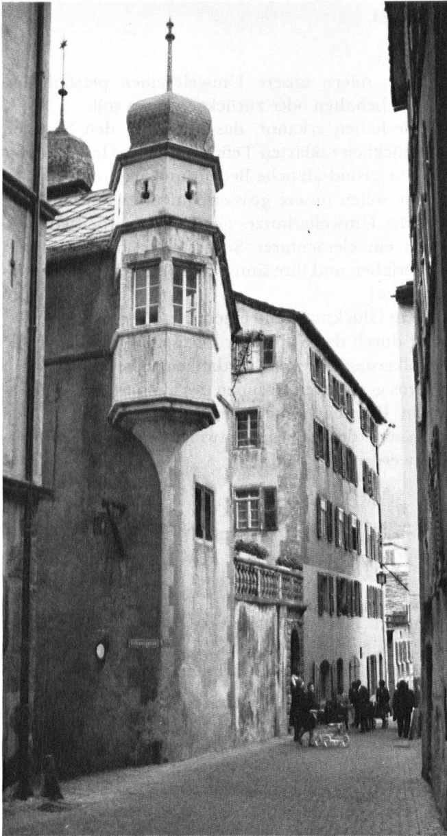
Links: Das alte, restaurierungsbedürftige Stockalperhaus in Brig, mit den beiden Zwiebeln des Erkers und des Treppenturmes. Rechts: Die doppelstöckige Verbindungsgalerie zum Stockalperschloss.
