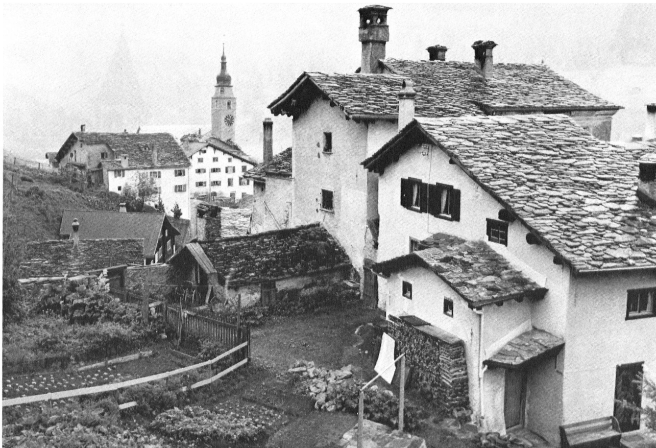
Le village de Splügen GR. Les toits sont couverts de dalles de pierre. Au premier plan à droite, la propriété Schuhmacher, dont la toiture a été refaite aux frais du Heimatschutz, de la Confédération et du Canton. Plus loin, la maison Thöny a aussi sa toiture rénovée.
