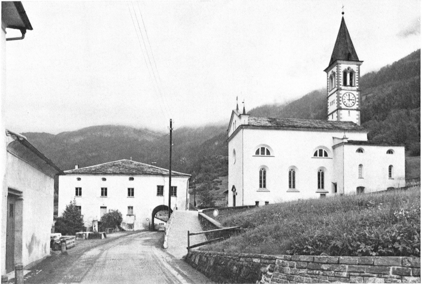
L'église et la maison de paroisse de San Carlo|Poschiavo forment une unité architecturale et donnent au village son caractère particulier. La disparition de la maison de paroisse et son «volt» (arc) très original serit une perte très sensible.
