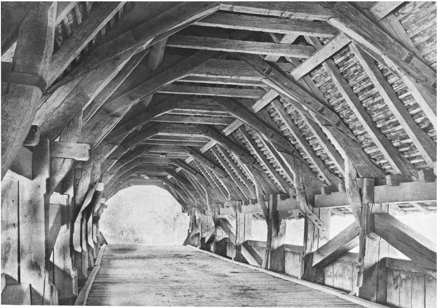
Inneres der Gümnenen-Brücke über die Saane bei Bern (1555). Unter dem massiven Berner Walmdach fügen sich Dachstreben und Bögen gleichsam zu einem Gewölbe ( Aufnahme 1913).
