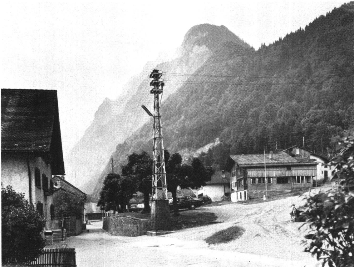
Näfels. Fahrtsplatz. Heutiger Zustand, der nach der alten Vorlage saniert werden soll; der hässliche Elektromast soll verschwinden
