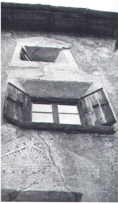
Links oben: Zu Beginn der Fassadentechnik wurden die Gebäude nur um Fenster und Türen überputzt und verziert.
