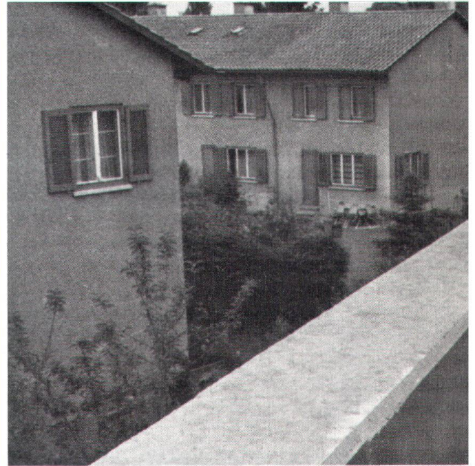
Principe d'aménagement n° 1: l'aménagement du territoire doit préserver les zones d'habitation des nuisances, telles que pollution de l'air, bruit et trépidations (photo Photopress).
