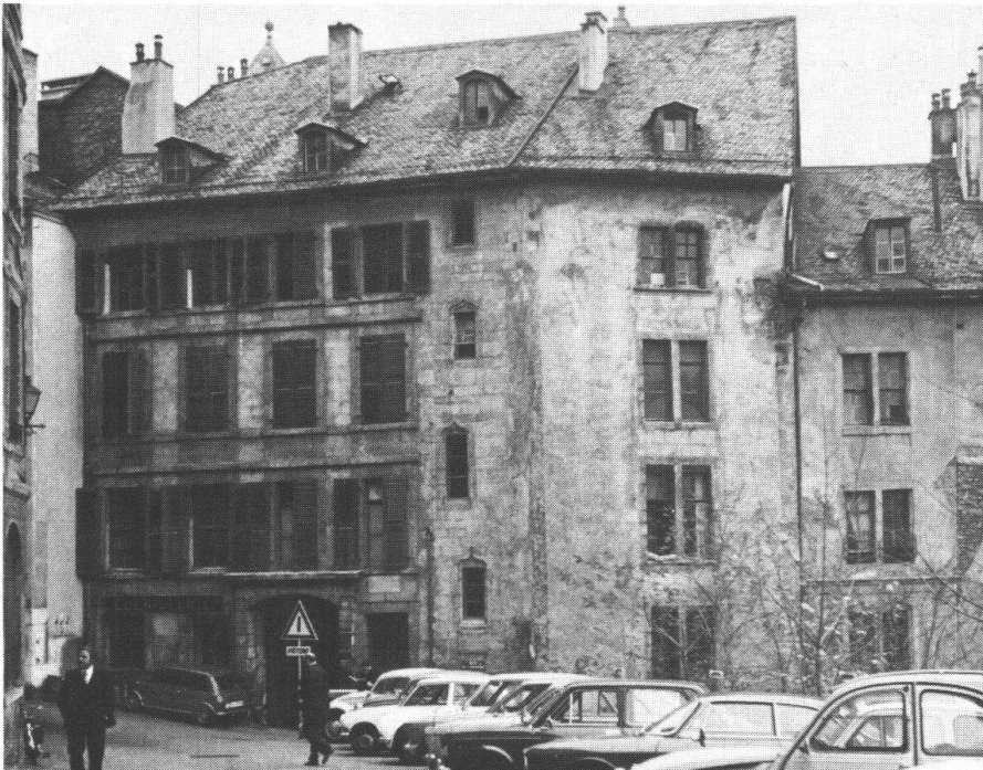
L'immeuble 18 rue de la Pélisserie sera conservé et restauré. Suite à diverses investigations, plusieurs éléments intéressants ont été identifiés dans ce bâtiment (tourelle d'escalier, plafonds, traces de peintures, etc.) (photo Baertschi).
