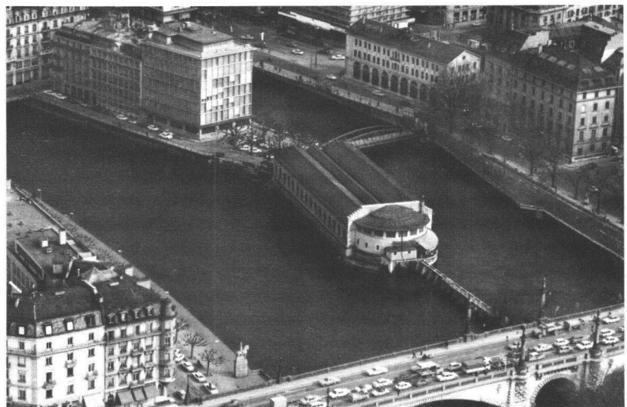
Vue aérienne de l'Île avec les anciennes halles (photo Trepper).
