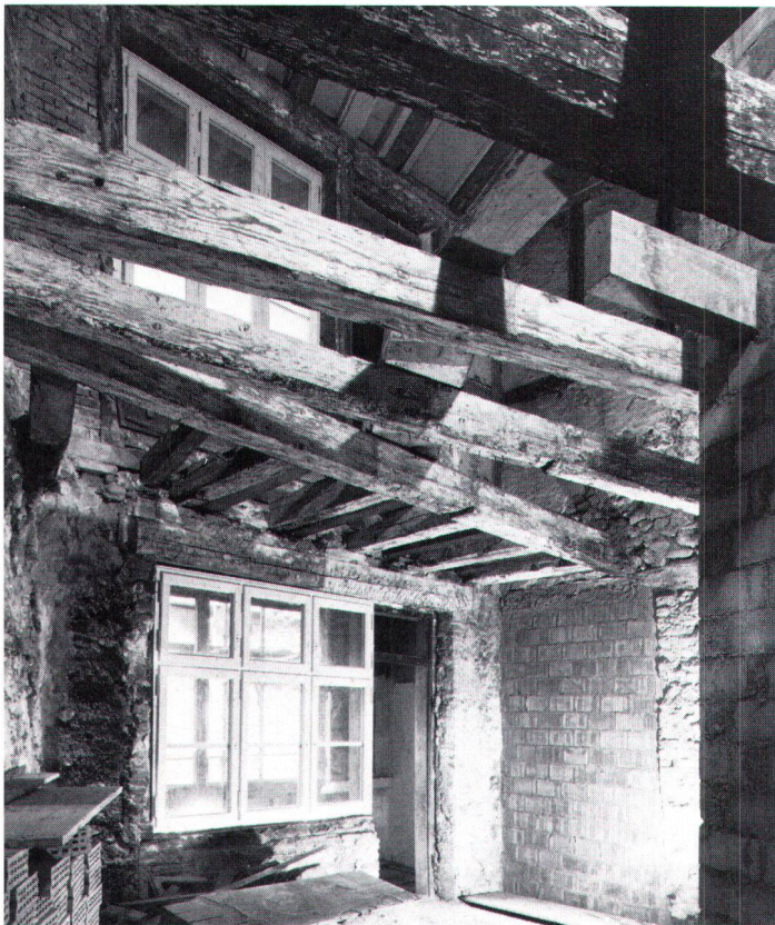
In Altbauten sollten die ursprünglichen Holzbalkendecken wenn immer möglich erhalten werden – aus optischen und statischen Gründen (Bild Hochbauamt Stadt Basel)
