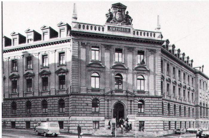
Fassade Amthaus Bern: Gutes Resultat trotz fragwürdiger Zielsetzung des Wettbewerbes (Bild Atelier 5)
