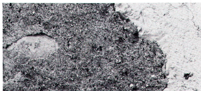
Détail d'un crépi ancien à la chaux en pâte. On remarque l'«accrochage» harmonieux du mortier à la pierre (photo Baertschi).
