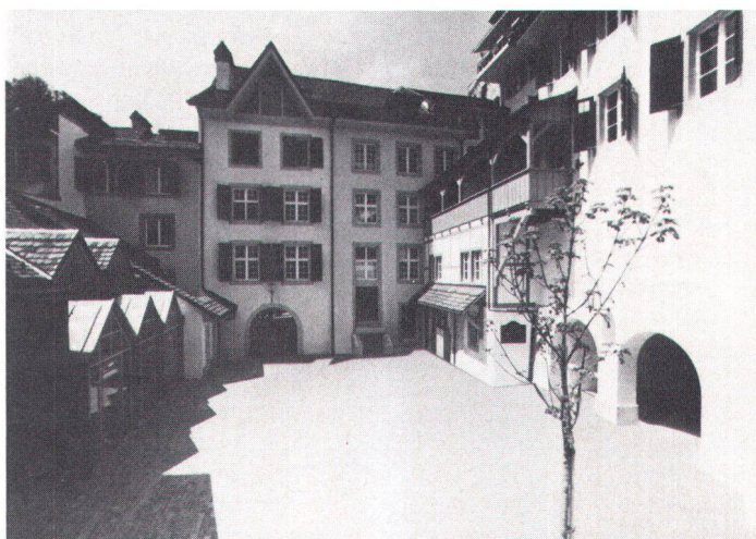
Das Herz des Vigierhofes, der Hof, ist als einziger der Solothurner Altstadt öffentlich zugänglich (Archivbild) Cette cour, au cœur du quartier du Vigier, est la seule du Vieux-Soleure qui soit accessible au public.
