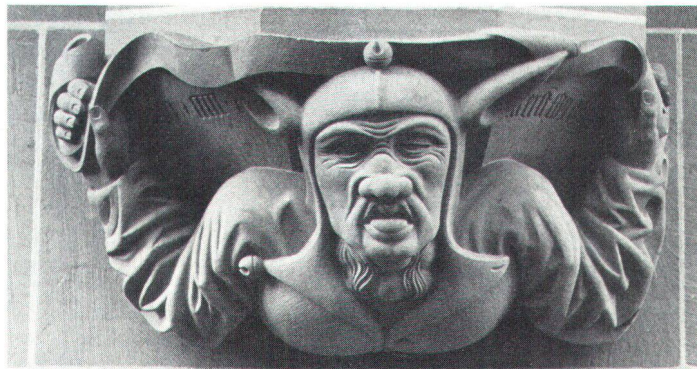
«Leidensweg» einer umweltgeschädigten Steinplastik am Berner Münster. Oben: Zustand 1969; Mitte: 17 Jahre später; unten die Kopie 1987 (Bilder Stähli).
