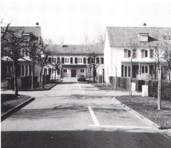
Kolonie der Genossenschaft «Selbsthilfe» (Bild Keller) Lotissement de la coopérative «Selbsthilfe».
