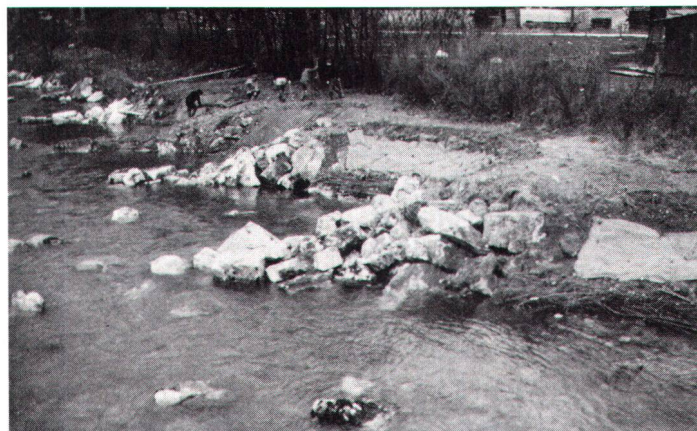
Die vorhandenen Steine wurden umgelagert zu fischfreundlichen und ingenieurbiologisch befestigten Buchten (Bild Zeh). Les pierres naguère alignées le long de la rive forment maintenant des anses favorables aux poissons et consolidées de façon naturelle.
