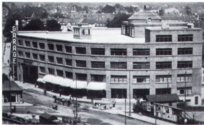
Zum Abbruch bestimmt: Grossgarage Schlotterbeck in Basel, errichtet 1928 durch W. E. Baumgartner und H. Hindermann (Bild SBZ).
