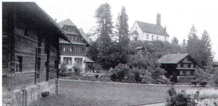
In Flüeli-Ranft OW ist nicht das Geburtshaus von Niklaus von Flüe, sondern der Grünraum darum herum gefährdet (Bild ISOS) A Flüeli-Ranft OW, ce n'est pas la maison natale de Nicolas de Flue qui est menacée, mais l'espace vert environnant.
