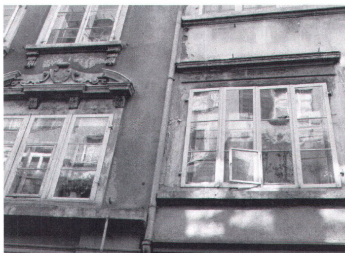
Fenêtre de gauche, au centre: nouvelles vitres du type Float. Fenster links, Mitte, mit ersetzten Floatgläsern (Bild Schneeberger).
