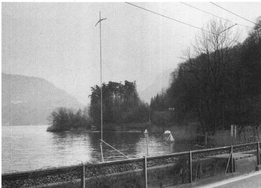
Das Auflageprojekt für den Ausbau der N2 entlang der Bucht bei Horw LU hatte eine Aufschüttung gemäss der im Bild sichtbaren Profilierung erfordert. In Verhandlungen konnten die Heimatschützer erhebliche Verbesserungen erreichen.
