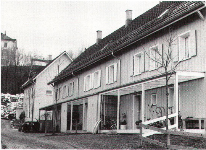
Zu den analysierten Neubauten gehörte die Siedlung «Grimmenstein» in Walzenhausen (Bild Früh).
