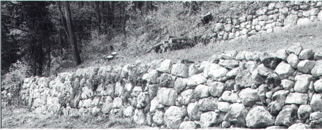
Die Rebbergmauern bei La Neuveville werden ohne Mörtel und nur mit behauenen Jurakalksteinen gefertigt und bilden wertvolle Nischenbiotope für eine artenreiche Fauna und Flora. (Bild FLS) Au-dessus de La Neuveville, les murs de vignes sont faits de pierres sèches (calcaire du Jura) et constituent un précieux biotope pour une flore et une faune riches en espèces.
