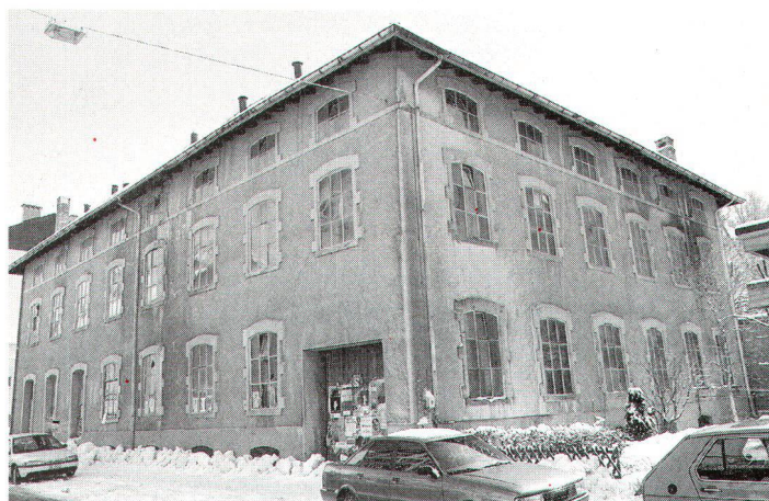
Vue extérieure et intérieure de l'ex-fabrique de chocolat Klaus, qui va être aménagée à l'intention de petites entreprises techniques et d'organismes d'expositions.
