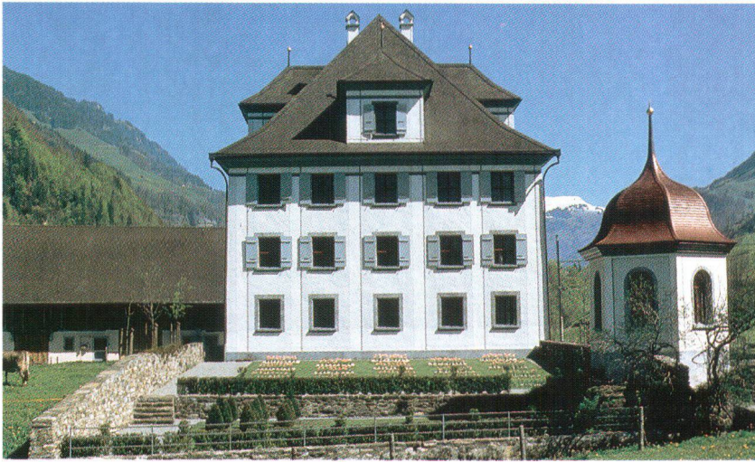
Nach der Erfassung 1995 vom Büro Hager umfassend restauriert: der zweistufige Barockgarten mit Pavillon vor dem Herrenhaus in Grafenort OW. (Bild Vogel) Le jardin sur deux niveaux et le pavillon du manoir de Grafenort (OW), complètement restauré par le bureau Hager après l'inventaire de 1995
