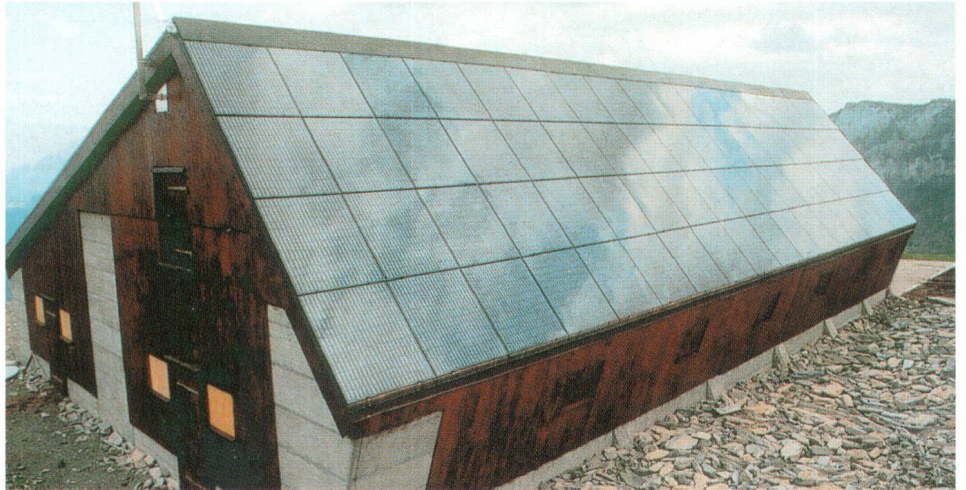
Die Einkleidung eines Daches mit Solarzellen wird bei der Alp Findels ob Pfäfers SG als eigenes gestalterisches Element wahrgenommen. (Bild TNC Consulting AG)
