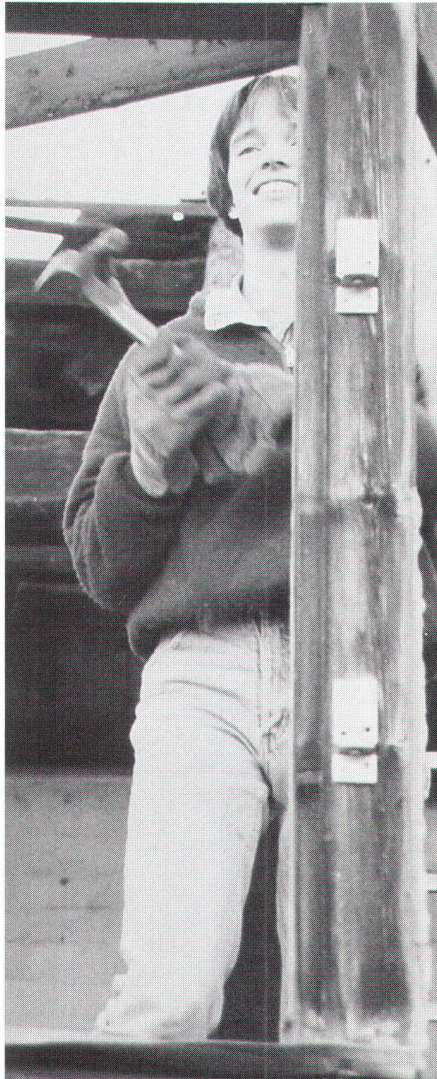
Nils Fretz legt selber Hand an bei der Sanierung seines Dachstuhls (Bild SHS)
