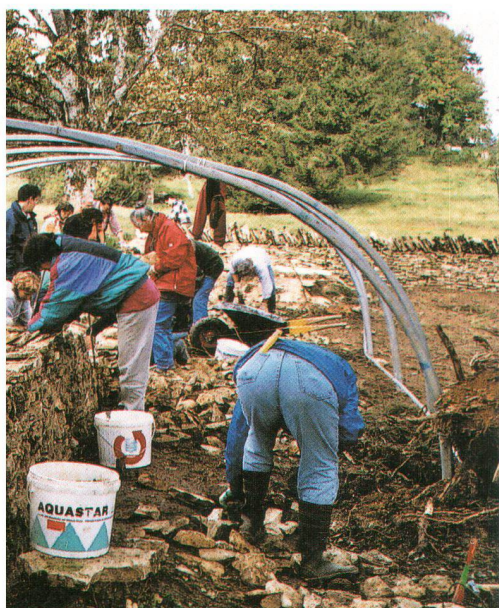
Instantané de la semaine 2002 de restauration de murs de pierres sèches (photo P. Jann)
