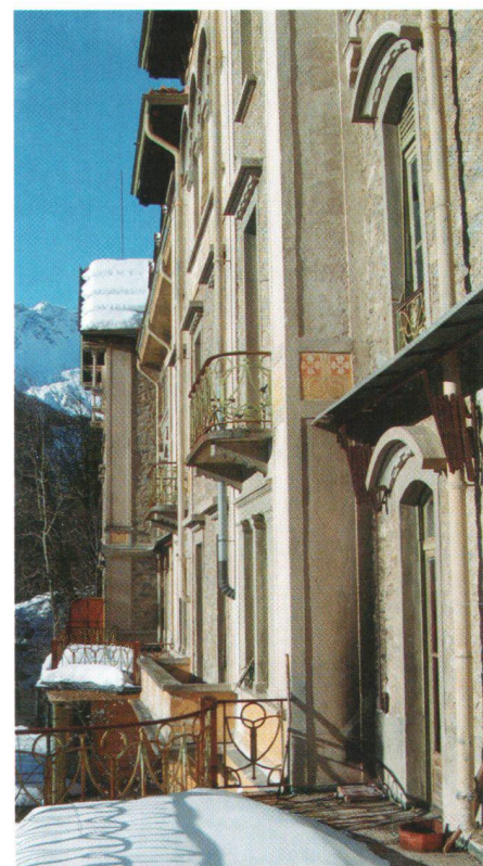
Die Rote Liste des SHS weist auf bedrohte Bauten hin und bildet die Brücke zwischen Angebot und Nachfrage. Hier das Sanatorio in Altanca TI (Bild SHS)
