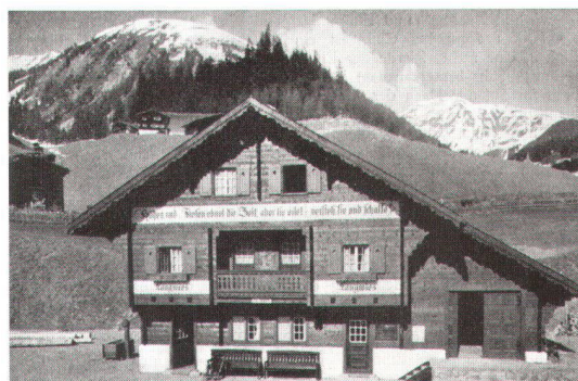
Bodenständige Holzkonstruktion prägt den Bahnhof Langwies (aus «Heimatschutz» 6/1915)
