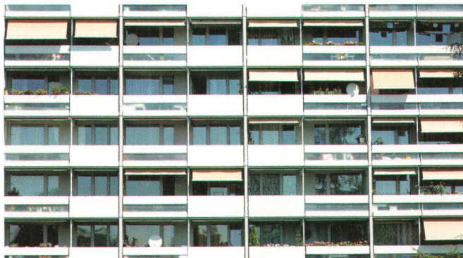
Cité Tscharnergut, Berne Bümpliz (photo Dominique Wehrli)
