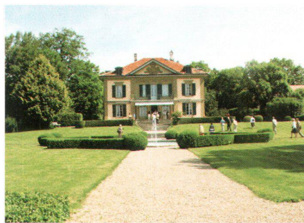
Villa de Weck, Pierrafortscha (1841–1846) (photo/Bild Denis de Techtermann)
