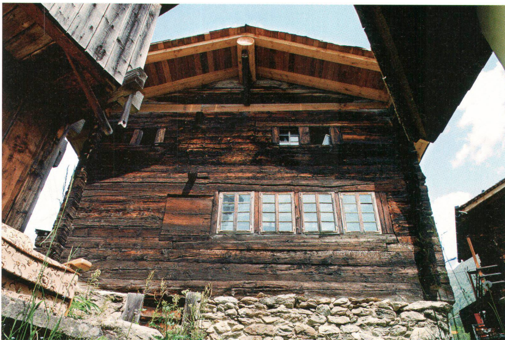
Das Huberhaus im Herbst 2006 vor der Renovation (Bild Matthias Arnold)
