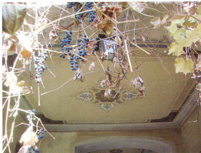
Bei der Casa Avanzini begegnet Natur mit den wunderschönen Deckenmalereien (Bild SHS)
