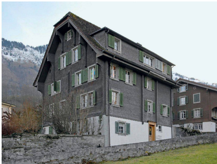
Stans, maison de l'organiste, Knirigasse 5, année de construction 1720. Vue depuis le nord-est
