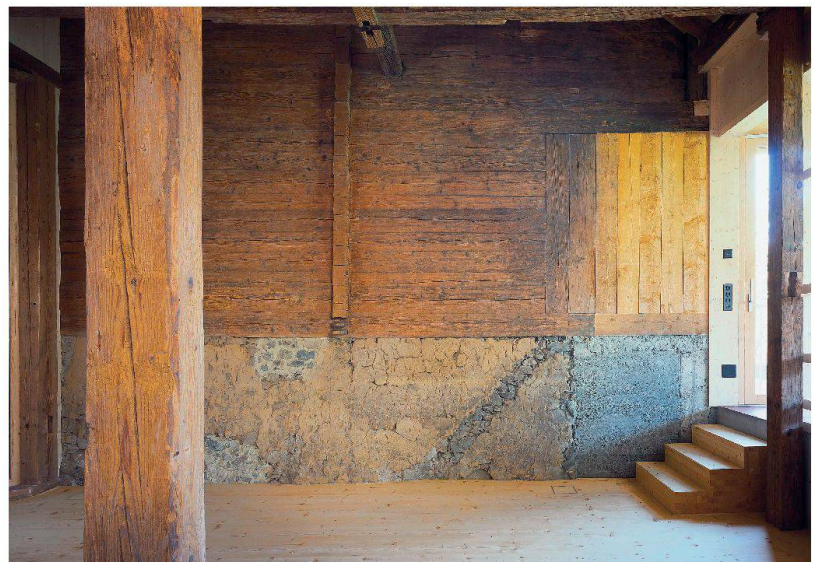
Unten: Sanftes Sanierungskonzept: Mit Tannenholz wird, wo nötig, die vorgefundene Substanz ergänzt. (Foto: Future Photography, Erica Overmeer)
