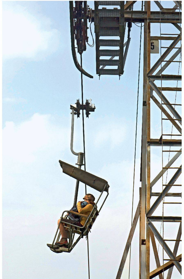
Seit bald vier Jahren setzt sich der SHS für den Erhalt des historischen Sesselliftes auf den Weissenstein ein (Bild SHS)
