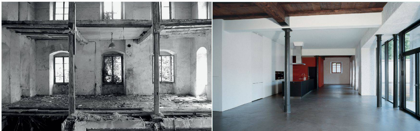
Links: Das Innere nach der mutwilligen Zerstörung. Rechts: Die Loft-Wohnungen besetzen jeweils ein ganzes Geschoss. (Bilder Werner Schmutz, Christine Seiler)
