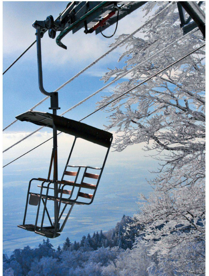
Der 1950 in Betrieb genommene Sessellift am Solothurner Weissenstein – ein Denkmal von nationaler Bedeutung. (Bild SHS)
